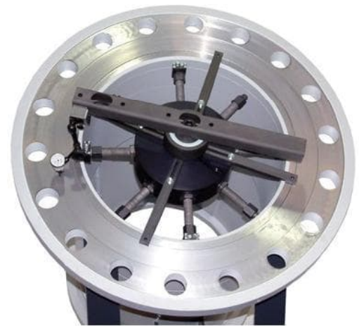
Установка и выверка зажимного устройства
